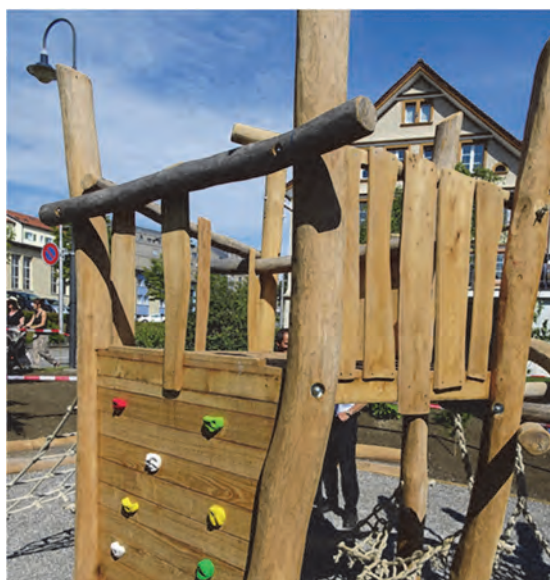
Illustration 9 Équipement de jeux avec garde-corps et balustrade
