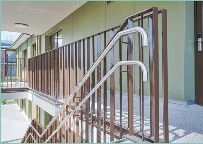
Illustration 7: mains courantes conformes à la norme
